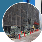
現場の防犯対策
