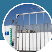
工事車両出入口
